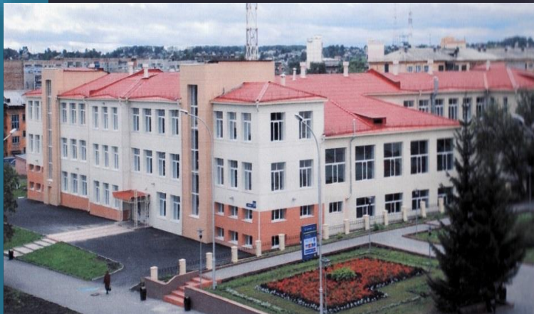
Школа после ремонта
